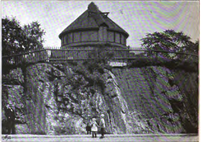
Foldningsforkastning ved Drammensveien.
